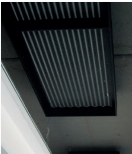
Passiver Kühlbalken KB-1 zum verdeckten Einbau in abgehängte Decken. Der Kühlbalken ist schwarz matt pulverbeschichtet. Andere Farben sind möglich
